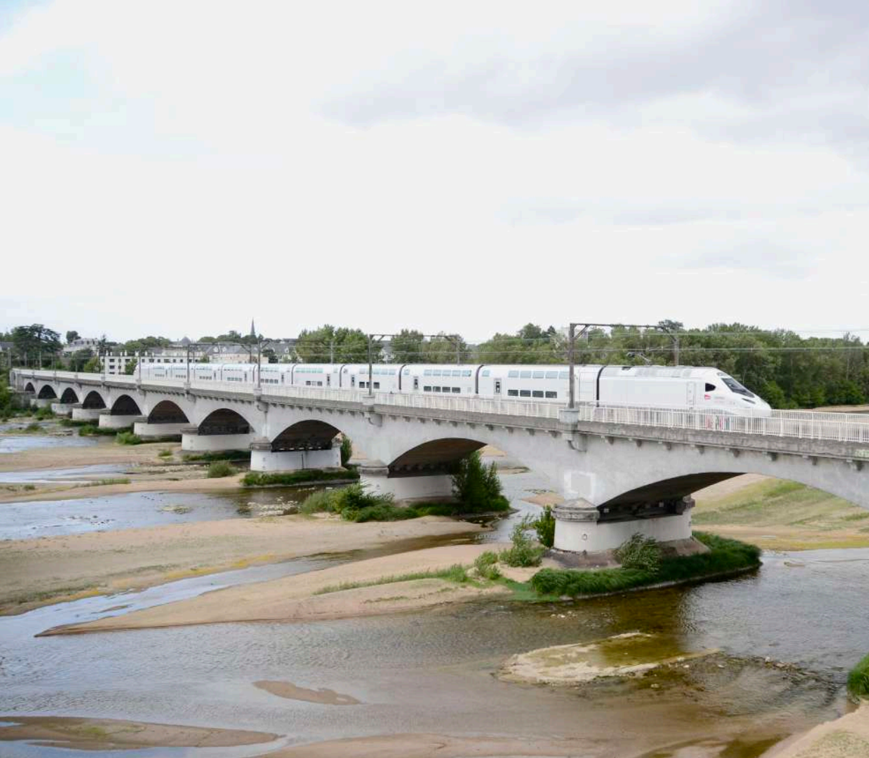
▲ Première campagne d'essais pour la rame Avelia Horizon n°997 «PS2» franchissant la Loire à Orléans
